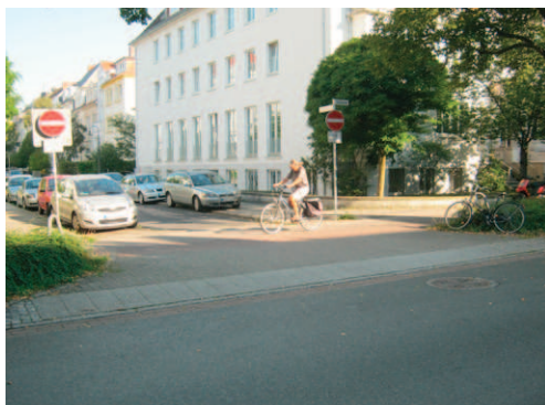
Radwegüberfahrten mit Verwendung von Rampenformsteinen (Bremen) Hinweis: erforderliche Furtmarkierung fehlt
